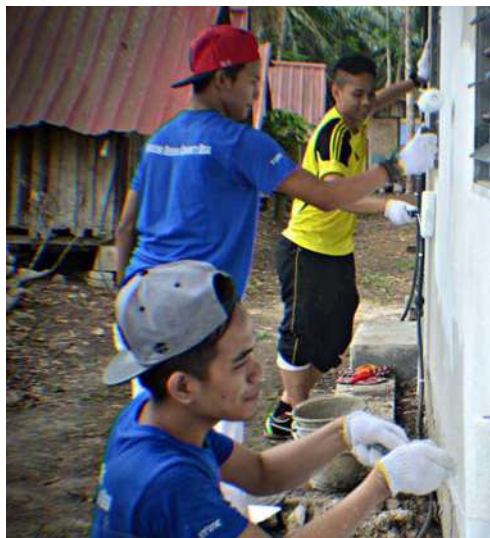
Gotong-royong mengecat bangunan di sekitar Kg. Bukit Hijau
