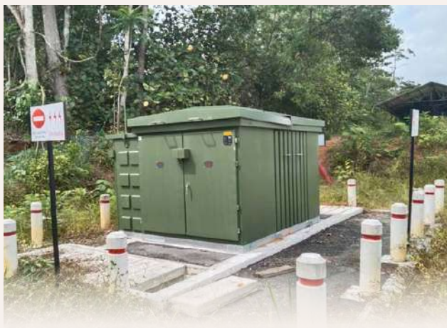
Pemasangan kemudahan elektrik.
