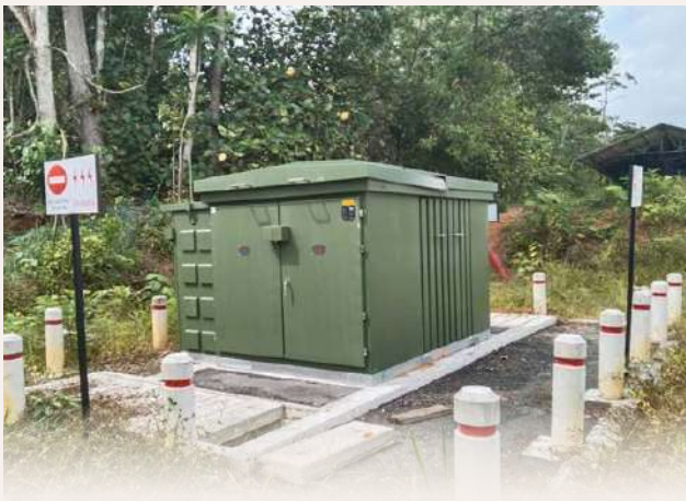
Pemasangan kemudahan elektrik.
