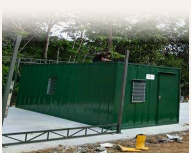
Pemasangan kabin untuk pejabat, bilik penginapan.
