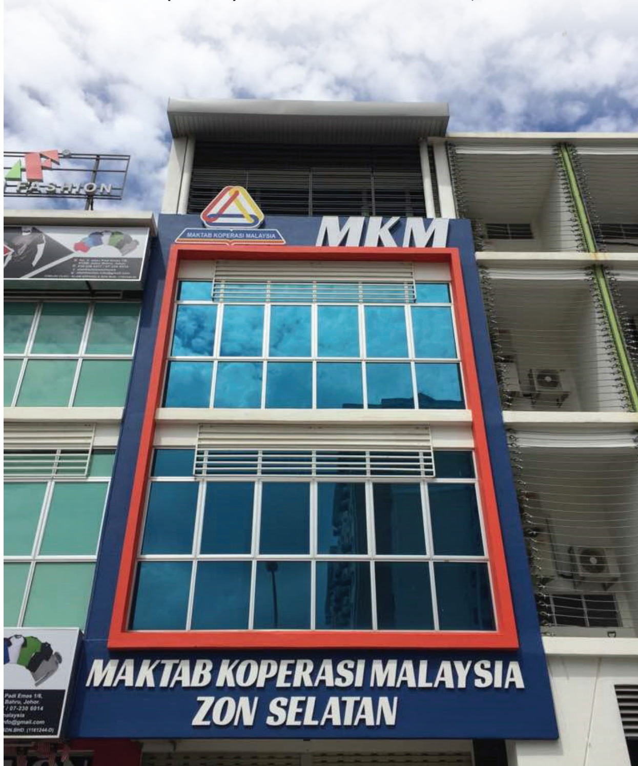
Pandangan depan bangunan baru MKMZS
